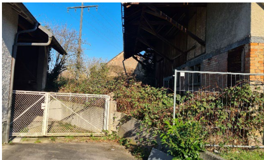
Abb. 9: von Brombeeren überwuchelter Bereich zwischen den Nebengebäuden; hinten: Holunder
